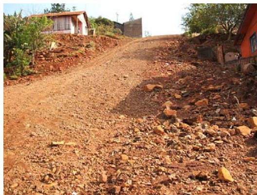
Figura 6: Habitações com riscos de deslizamento Fonte: ECOTÉCNICA, 2005
