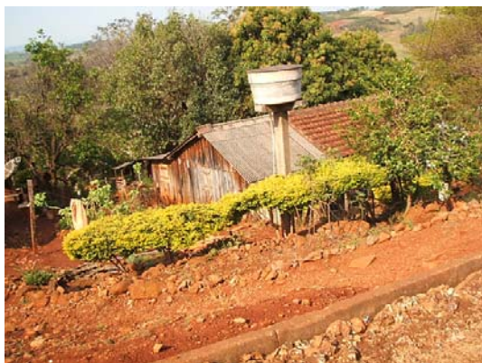
Figura 5: Habitação com riscos de soterramento Fonte: ECOTÉCNICA, 2005
